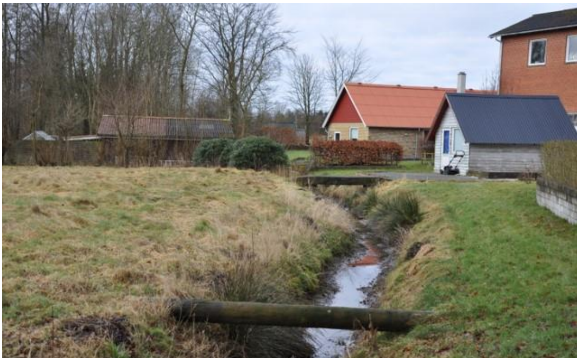
Kanalen i skel ved Aahavevej 2
